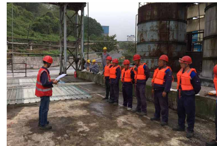
现场施工安全技术交底
