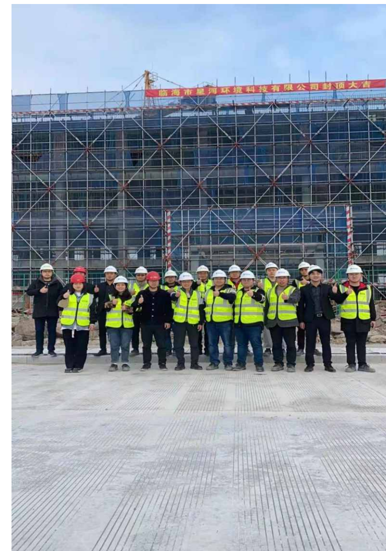
2022年03月 办公楼封顶
