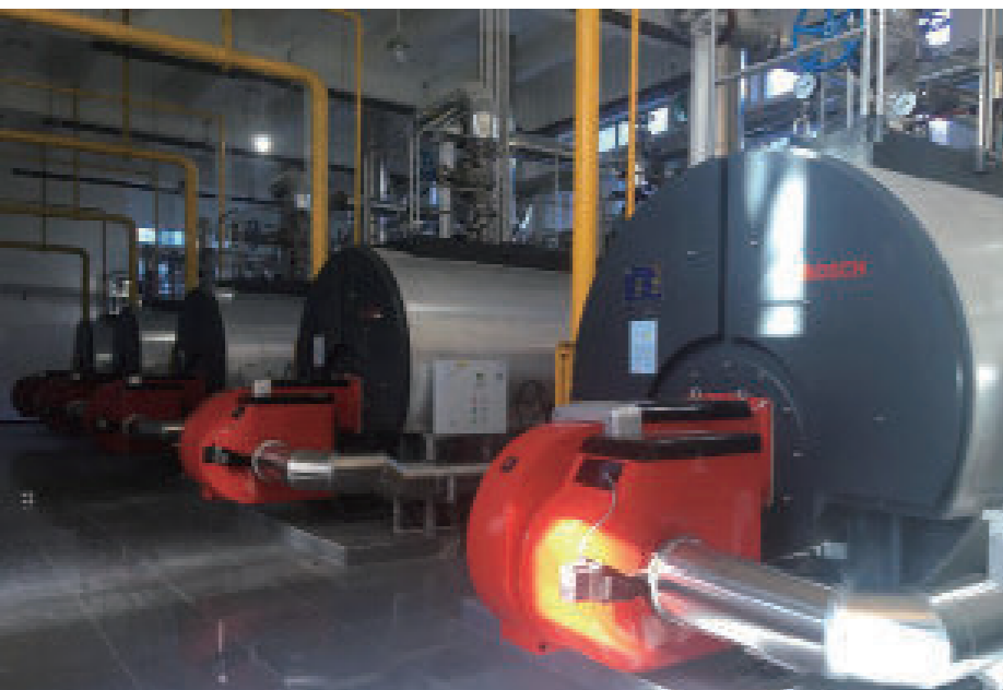
安装地：北京外国语大学 锅炉型号：4.2MW 热水锅炉 5台 燃烧器型号：5台 GP-450A WD200 DN65 FGR NOx 排放：< 30mg/Nm 3
