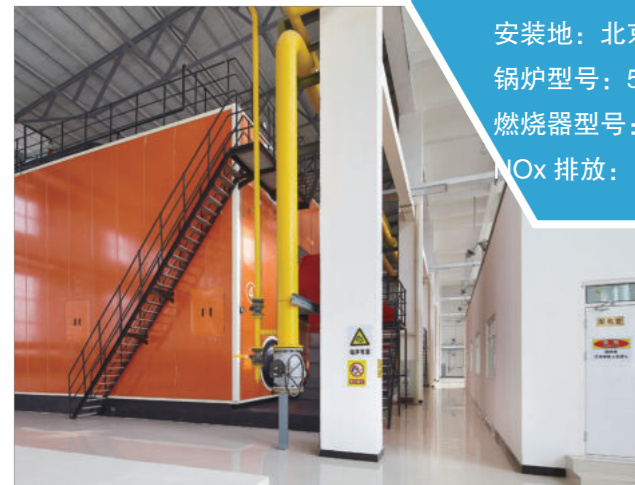
安装地: 北京天阳供暖 锅炉型号: 29MW 热水锅炉 3台 燃烧器型号 GT-35A FGR NOx 排放: < 30mg/m 3 n
