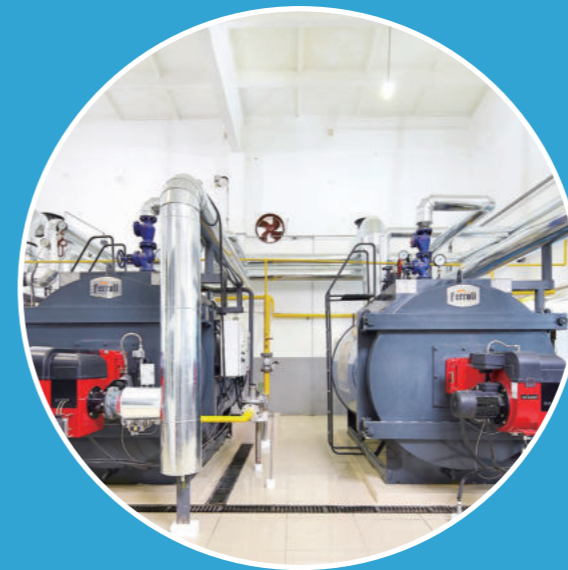
安 装 地：北京紫竹院 锅炉型号：1.4MW 热水锅炉 1台 2.1MW 热水锅炉 1台 燃烧器型号：GP-140M FGR GP-250M FGR NOx 排放：< 30mg/m 3 n
