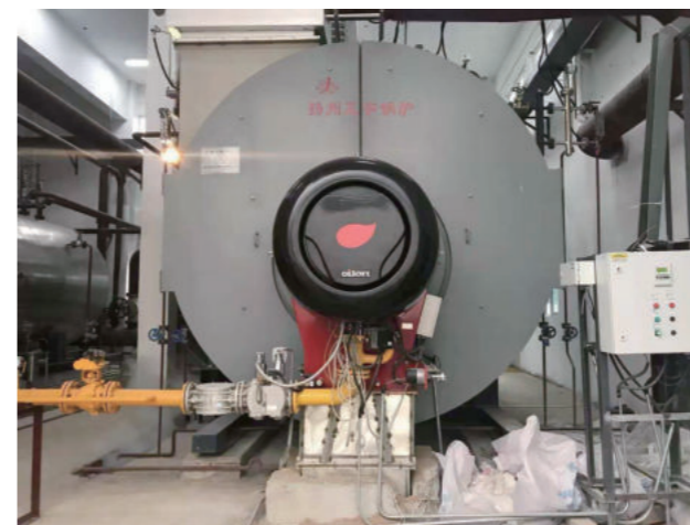
安装地：郑州露露 锅炉型号：10 吨蒸汽锅炉 1 台，20 吨蒸汽锅炉 1 台 燃烧器型号：GT8A WD200 FGR/ GT16A WD200 FGR NOx 排放：< 30mg/m 3 n
