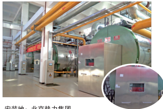
安装地：北京热力集团 锅炉型号：14MW 热水锅炉 3 台 燃烧器型号：GP-1600ME FGR NOx 排放：< 30mg/m 3 n
