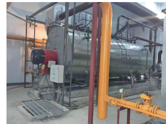
安装地：郑州露露 锅炉型号：10 吨蒸汽锅炉 1 台，20 吨蒸汽锅炉 1 台 燃烧器型号：GT8A WD200 FGR/ GT16A WD200 FGR NOx 排放：< 30mg/m 3 n
