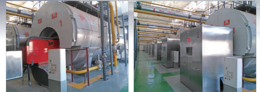
安装地：北京热力集团 锅炉型号：14MW 热水锅炉 10 台 燃烧器型号：GP-1600ME FGR NOx 排放：< 30mg/m 3 n
