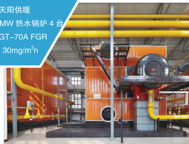
安装地: 北京天阳供暖 锅炉型号: 29MW 热水锅炉 3台 燃烧器型号 GT-35A FGR NOx 排放: < 30mg/m 3 n
