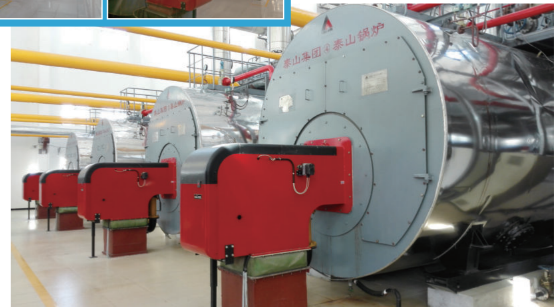
安装地：北京热力集团 锅炉型号：14MW 热水锅炉 9 台 燃烧器型号：GP-1600ME FGR NOx 排放：< 30mg/m 3 n
