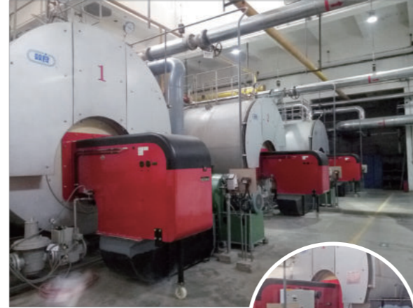
安装地：北京热力集团 锅炉型号：10.5MW 热水锅炉 3 台 燃烧器型号：GP-1200ME FGR NOx 排放：< 30mg/m 3 n
