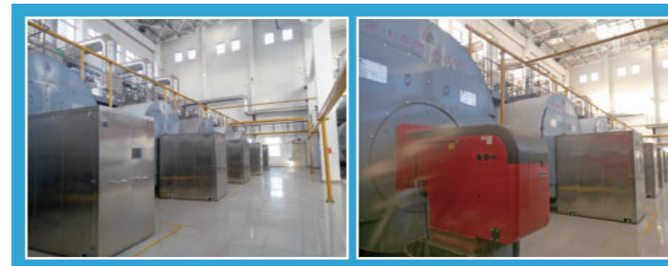
安装地：北京热力集团 锅炉型号：14MW 热水锅炉 9 台 燃烧器型号：GP-1600ME FGR NOx 排放：< 30mg/m 3 n
