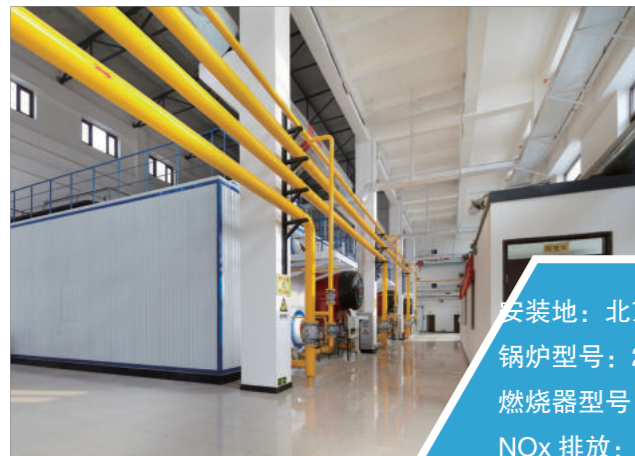
安装地: 北京天阳供暖 锅炉型号: 58MW 热水锅炉 4台 燃烧器型号: GT-70A FGR NOx 排放: < 30mg/m 3 n
