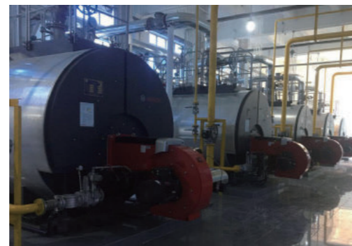
安装地：北京外国语大学 锅炉型号：4.2MW 热水锅炉 5台 燃烧器型号：5台 GP-450A WD200 DN65 FGR NOx 排放：< 30mg/Nm 3
