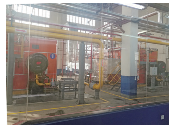
安装地：秦川机床集团有限公司 锅炉型号：20T 蒸汽锅炉 2 台 燃烧器型号：GT-19A FGR NOx 排放：< 30mg/m 3 n
