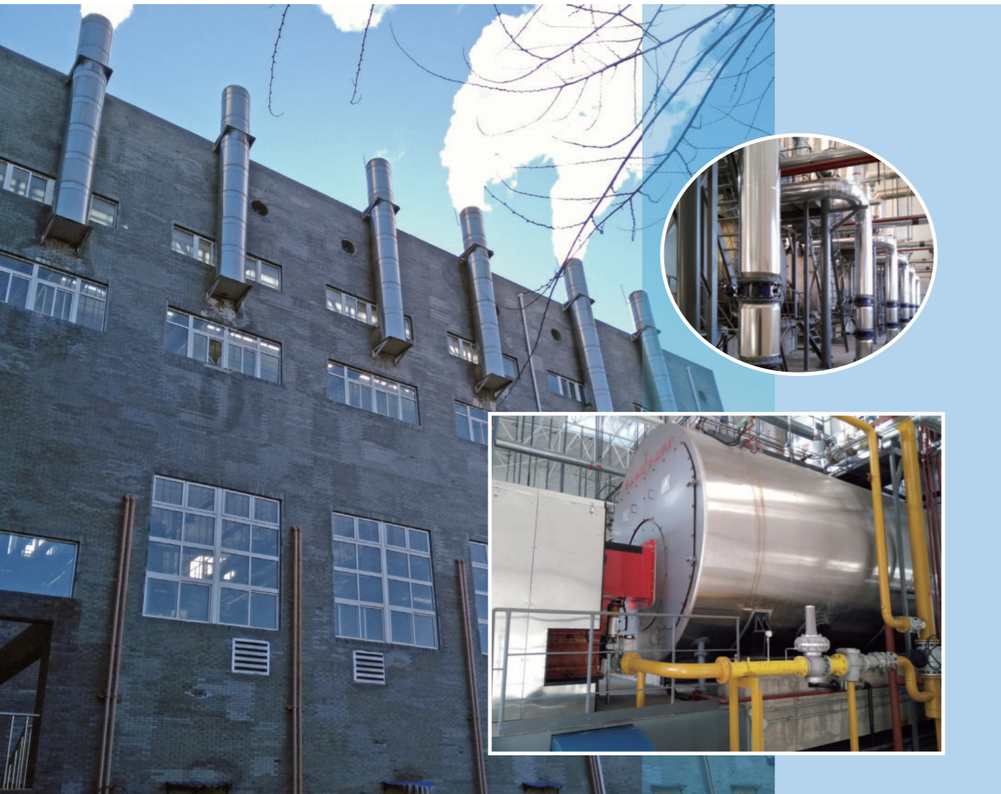
安装地：北京热力集团 锅炉型号：14MW 热水锅炉 6 台 燃烧器型号：GP-1600ME FGR NOx 排放：< 30mg/m 3 n
