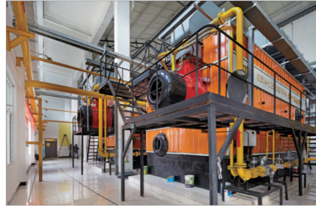
安装地: 北京天阳供暖 锅炉型号: 29MW 热水锅炉 /14MW 热水锅炉 燃烧器型号: GT-35A FGR /GT-16A FGR NOx 排放: < 30mg/m 3 n
