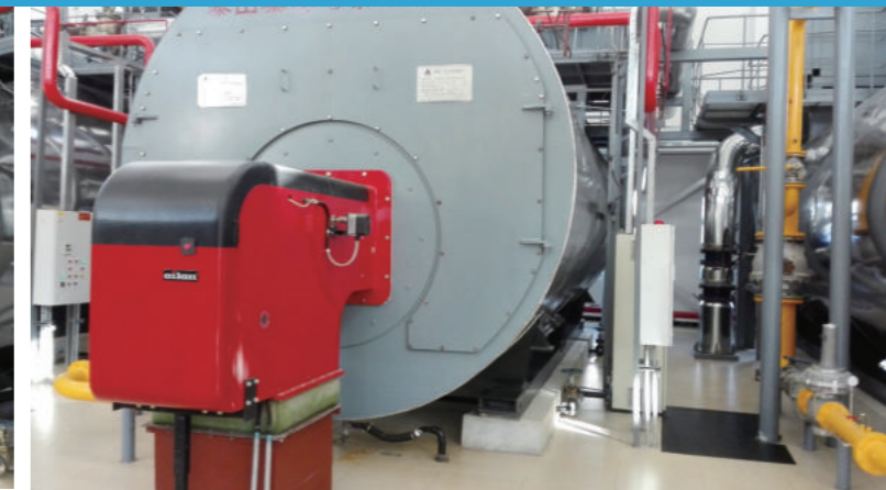
安装地：北京热力集团 锅炉型号：14MW 热水锅炉 8 台 燃烧器型号：GP-1600ME FGR NOx 排放：< 30mg/m 3 n
